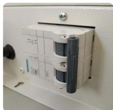
Disjuntor de proteção de sobrecorrente;
